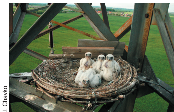
Fig. 10. Artificial nest on a pylon. Obr. 10. Umelé hniezdo na stožiarí.
