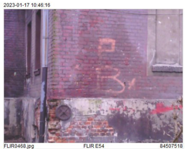
II. 16. Badanie termowizyjne fasad familoków w Bytomiu, Bobrku – widoczny podwójny efekt temperaturowy – silne zawilgocenie i efekt naroża, klatka schodowa nieogrzewwana. Fot. M. Krause-Świerczyńska, 01.2023
