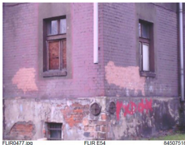
II. 18. Badanie termowizyjne fasad familoków w Bytomiu, Bobrku – narożnik typowego budynku. Lokalne wychłodzenie w miejscu większej ilości elementów metalowych (dobrze przewodzących ciepło), elementy metalowe przyjmują temperaturę otoczenia. Fot. M. Krause-Świerczyńska, 01.2023
