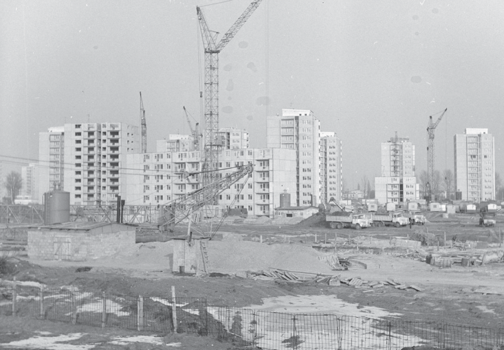
II. 1. Przykład uprzemysłowienia mieszkalnictwa w technologii ciężkiej w Polsce w latach siedemdziesiątych z użyciem prefabrykowanego betonu. Budowa Osiedla Stegny Warszawa, 1974. Autor: Rutowska Grażyna, ©Narodowe Archiwum cyfrowe, sygnatura 13/40/0/14/61, wolny dostęp, https://www.szukajwarchiwach.gov.pl/jednostka/-/jednostka/5914641/obiekty/256989#opis_obiektu (dostęp 27.09.2024).
