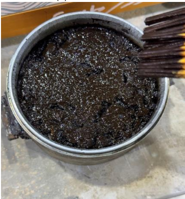
(d) Applying tack coat on binder layer
