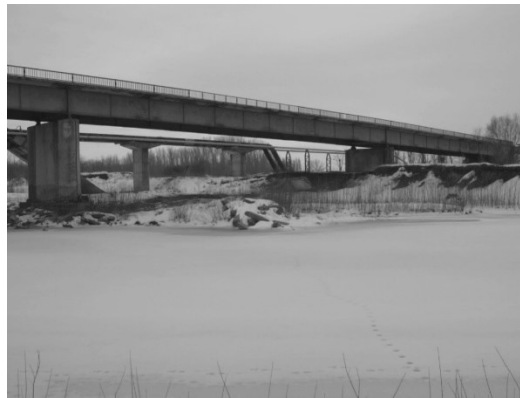
Fig. 1 – Longitudinal view of Șcheia Bridge
