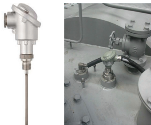
Slika 13: Izgled Pt100 senzora temperature i mjesto ugradnje [7]
