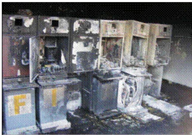
Slika 1: Primjeri eksplozije VN prekidača - posljedice i nastala razaranja [4]-[6]
