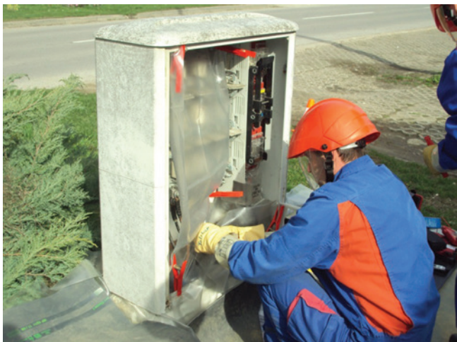
Slika 1: RPN izvođači elektromonteri Elektra Koprivnica: Rad na kabelskoj mreži
