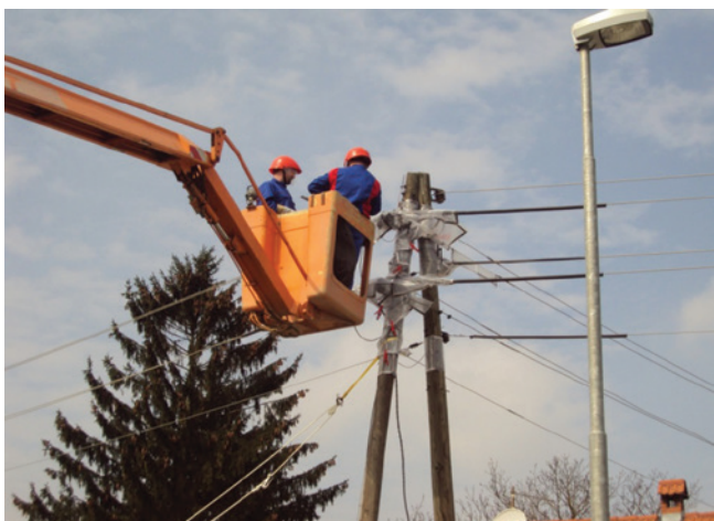
Slika 2: RPN izvođači elektromonteri Elektra Koprivnica: Rad na nadzemnoj mreži
