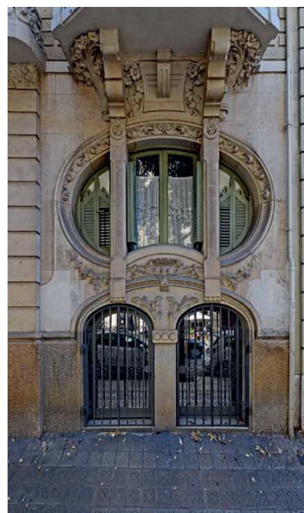
Fig. 56. Casa Vallet i Xiró I, Carrer de Mallorca, 302. 1912–1913. Josep Maria Barenys i Gambús. Fragment of the facade.
