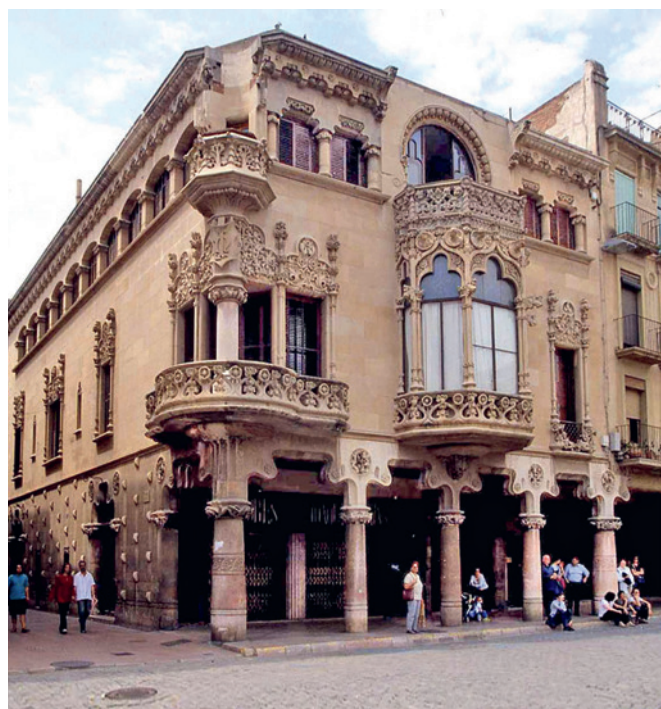
Fig. 25. Reus. Casa Navàs, Plaça Mercadal, 7. 1901–1907. Lluís Domènech i Montaner. 2000 photograph.
