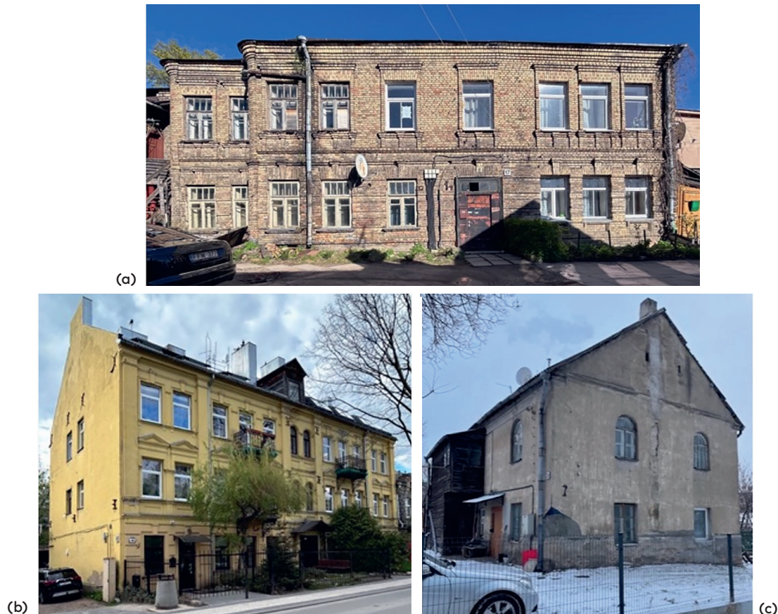
Fig. 5. Masonry buildings in Šnipiškės: (a) 17 Giedraičių St.; (b) 45 Giedraičių St.; (c) 39 Lviso St. [photos by the author].
