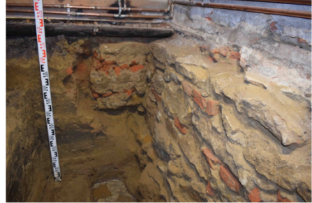
Imag. 18. În profilul de est s-a făcut o prospecțiune pentru a verificare starea și legătura fundației pilonului cu celelalte fundații.
