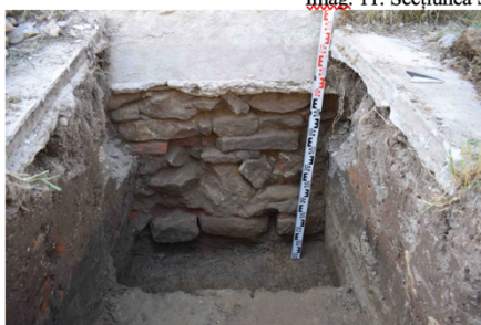
Imag. 12. Detalii cu fundația. S-a strâns apă relativ repede. Fundația stă pe argilă.
