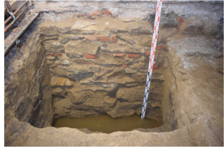
Imag. 17. S4 la final. Detalii cu fundația. La nivelul tălpii fundației se adună apă.
