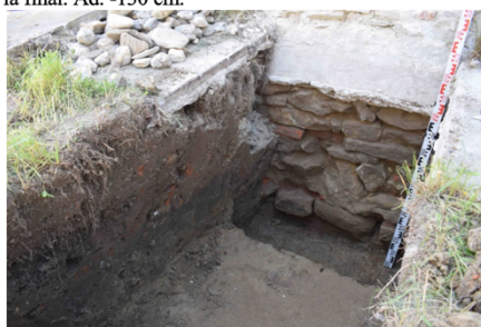
Imag. 12. Detalii cu fundația. S-a strâns apă relativ repede. Fundația stă pe argilă.
