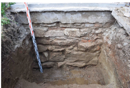
Imag. 4. Detalii cu fundația.
