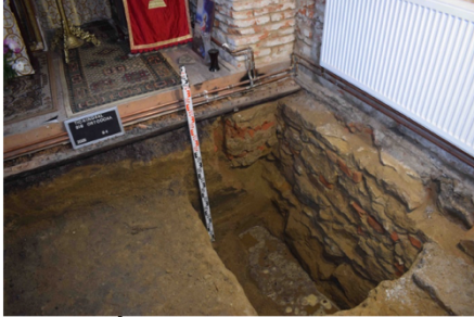
Imag. 18. În profilul de est s-a făcut o prospecțiune pentru a verificare starea și legătura fundației pilonului cu celelalte fundații.
