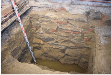
Imag. 17. S4 la final. Detalii cu fundația. La nivelul tălpii fundației se adună apă.
