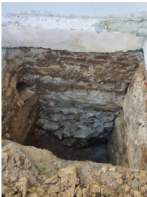
Fig. 8. Sibiel – C2: detaliu cu joncțiunea dintre fundația turnului clopotniță și a pronaosului
