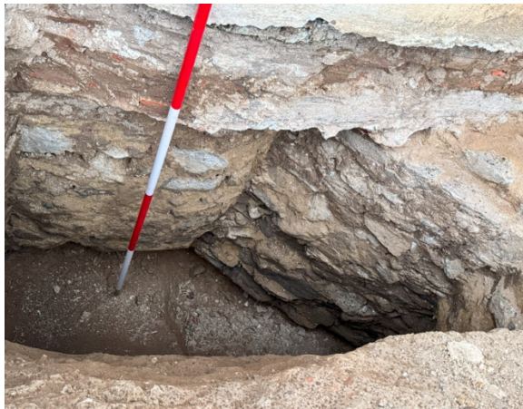
Fig. 7. Sibiel – C1: detaliul cu fundația unui mai vechi altar semicircular suprapusă de fundația actualului altar poligonal.
