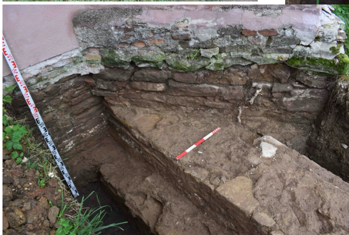
S5/2021. Fundațiile colateralei de nord și a navei se țes. De asemenea elevațiile contrafortului și a navei. Elevația contrafortului este așezată peste fundația fostei colaterale de nord.
