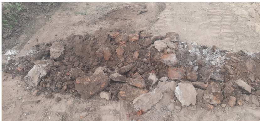
Fig. 20. Demontarea platformei (podina) pe traseul șanțului secundar
