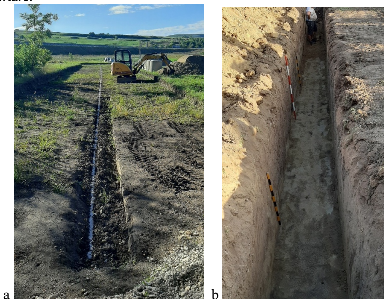
Fig. 3. Situația în teren la debutul lucrărilor, cu trasarea axei canalizării și a drumului de acces (a); detaliu din timpul realizării șanțului pentru instalarea elementelor de canalizare (b)
