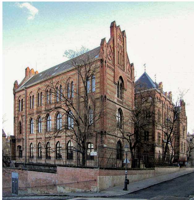
2. ábra. Toldy Főreál épülete
