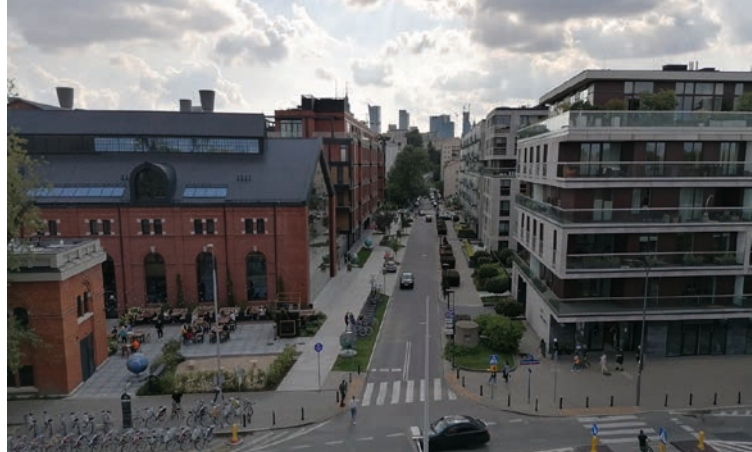
II. 12 Widok z dachu Centrum Nauki Kopernik w kierunku zachodnim na ciąg ulic: Drewnianej i Leszczyńskiej. Fot. T. Matwiejczuk, 2021
