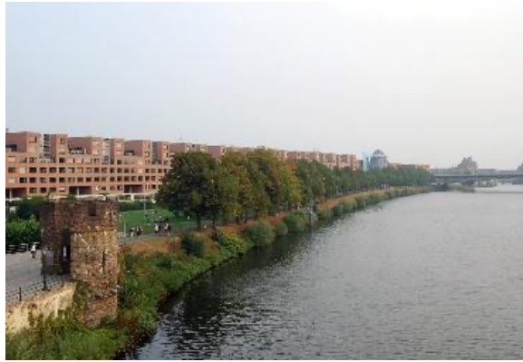
Fig. 6 STOA Residential Complex ( https://www.archiweb.cz/en/b/bytovy-soubor-stoa )
