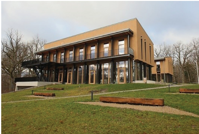
Fig. 11. The office building of “Latvijas Valsts meži” [37].
